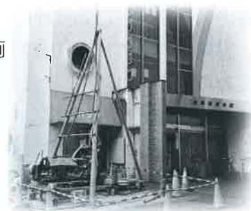
〈ボーリング調査の櫓〉
