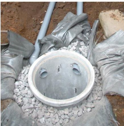
雨水浸透ます設置工事中
