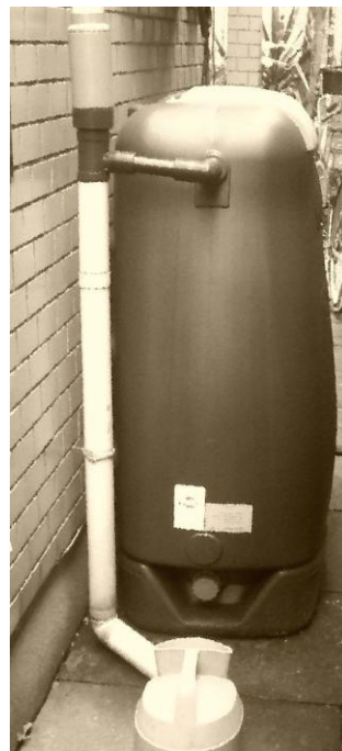
雨水貯留槽設置状況
